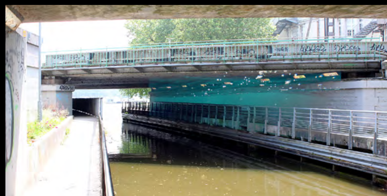
3 - TUNNEL #2 - projection vue dans l'autre
