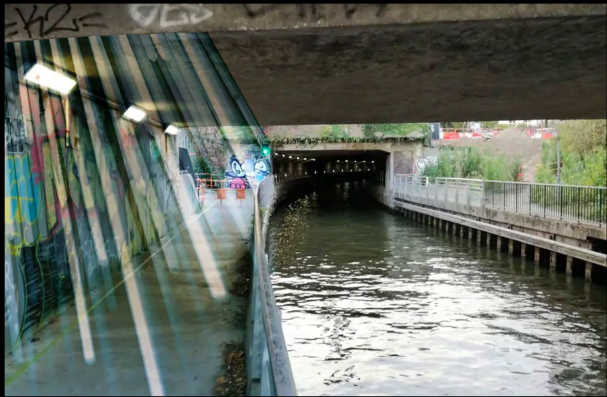
2 - INTERFÉRENCE: projection modifiée au passage de trains sur le pont
